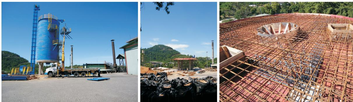
O cliente Realcafé optou por fazer de concreto armado a estrutura de sustentação do silo.
